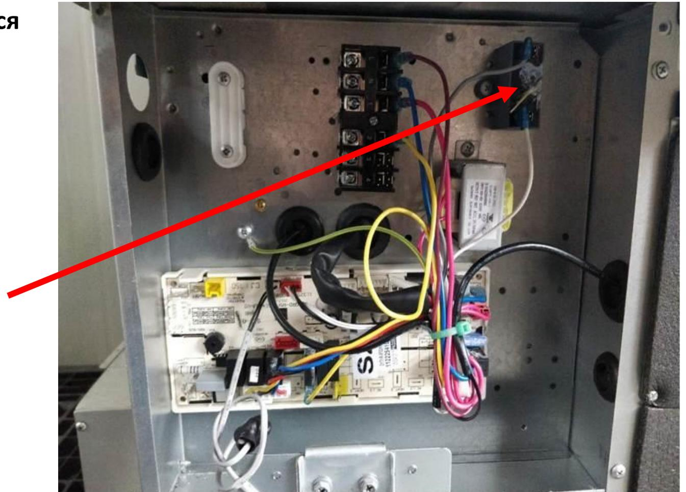
Демонтировав установленный конденсатор вентилятора внутреннего блока Вы снижаете напор статического давления с 80 Па до 50 Па, установив другой конденсатор (емкость ниже, чем у конденсатора изначально установленного)
