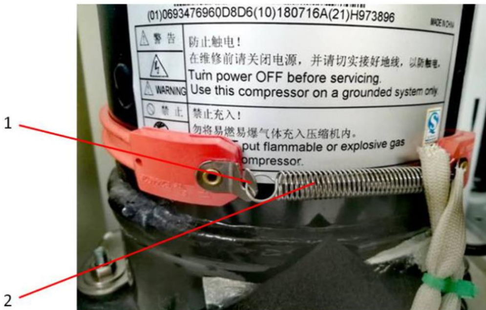
1 — пряжка 2 — пружинный крючок и пружина
